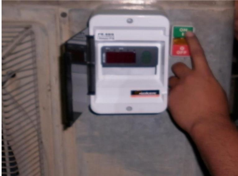
**Figura 3. Sensor de temperatura y encendido-apagado**
